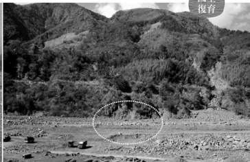
左圖為曾文越城引水的動和洞口，2005.12.17攝；八八災後荖濃溪河床墊高，洞口已深埋於土石下20幾公尺，如何復工？
