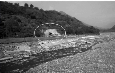
左圖為曾文越城引水的動和洞口，2005.12.17攝；八八災後荖濃溪河床墊高，洞口已深埋於土石下20幾公尺，如何復工？
