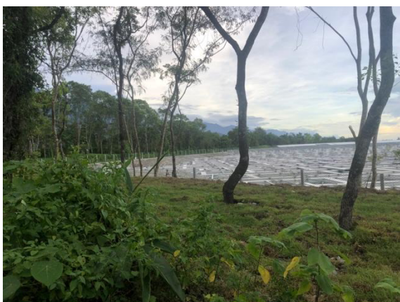
圖 14 生豐一期案場施工中，施作水泥固定基座
