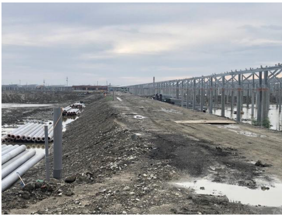
圖 17 七股地區施工中的光電案場
