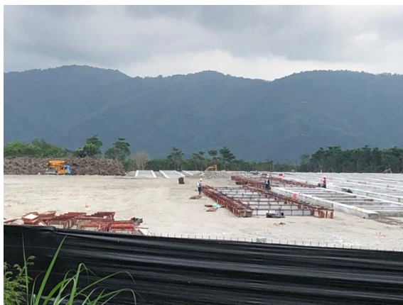
圖 13 生豐一期案場施作水泥固定基座
