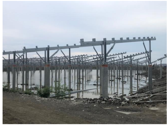
圖 18 七股地區施工中的光電案場
