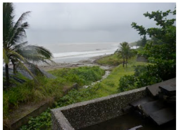
度假村的臨時更衣沖水間的污水是直接排入沙灘的!
