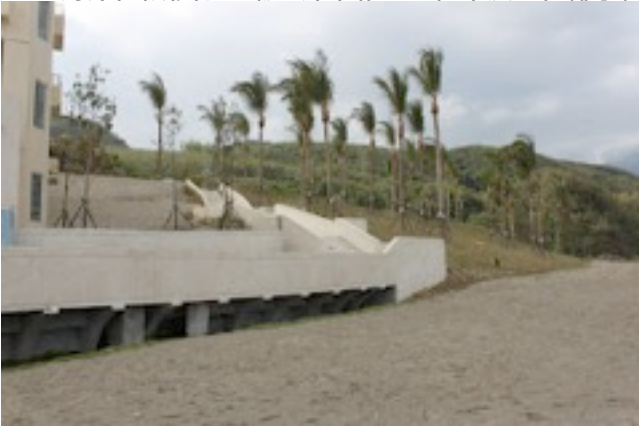
游泳池圍牆北側多出了磚砌的排水井
